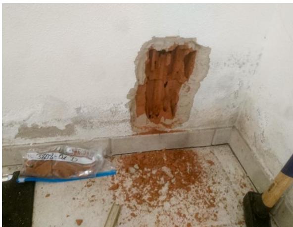
Abb.4a: Bauteilöffnung Mauerwerk, Material manuell gestemmt.
